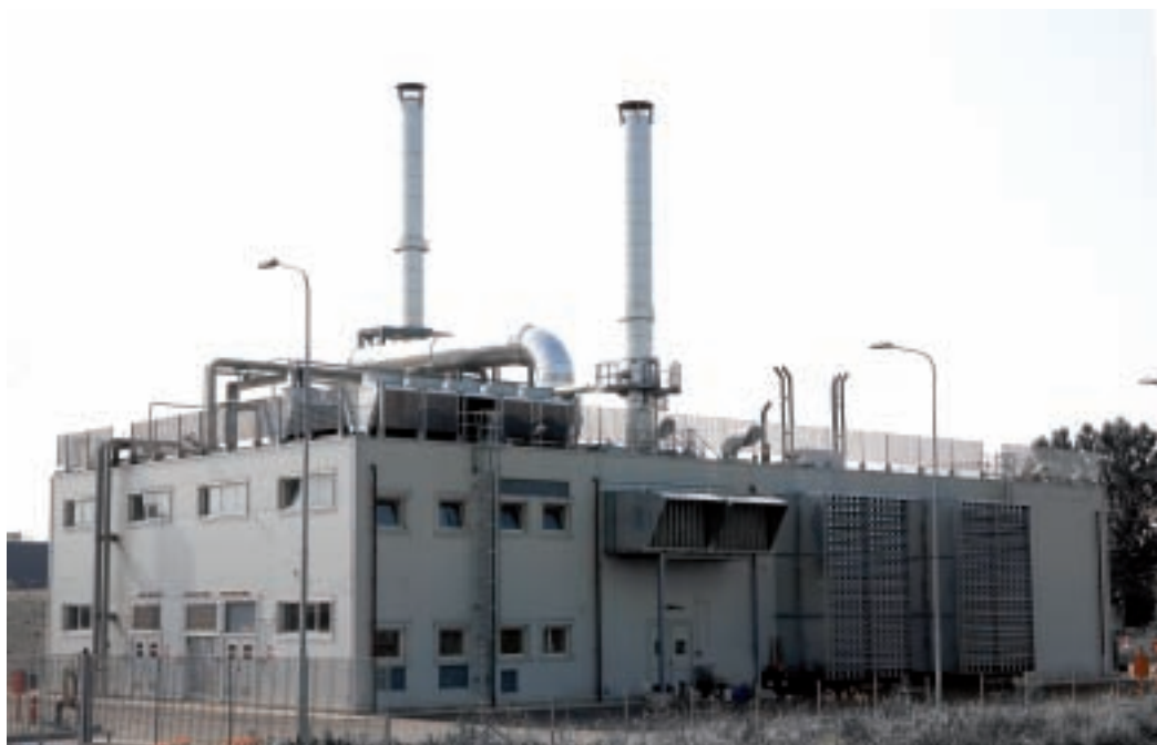
Figura 8 - Impianto di cogenerazione abbinato al teleriscaldamento
