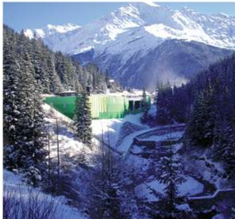
Impianto TCVTV Santa Caterina del Furva Sondrio
