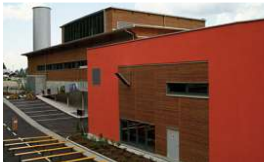
Impianto di teleriscaldamento Dobiaco San Candido Bolzano
