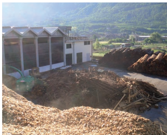
4 - Stoccaggio cippato (biomassa legnosa) impianto TCVVV Tirano
