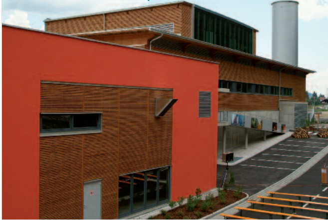
Teleriscaldamento termo elettrico Dobbiaco-S.Candido soc. coop. (BZ)
