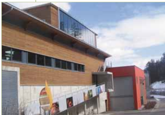
Coop. Teleriscaldamento Termo-Elettrico: Centrale di Dobbiaco - San Candido
