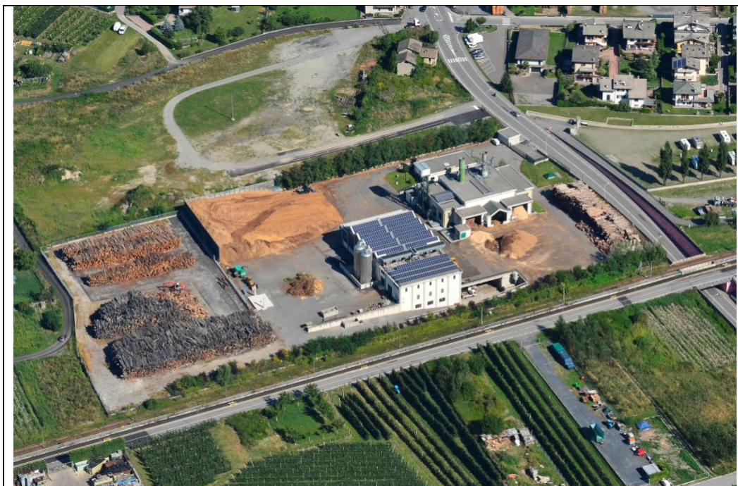
Figura 1 – Veduta aerea impianto di T.C.V.V.V. in Tirano (SO)
