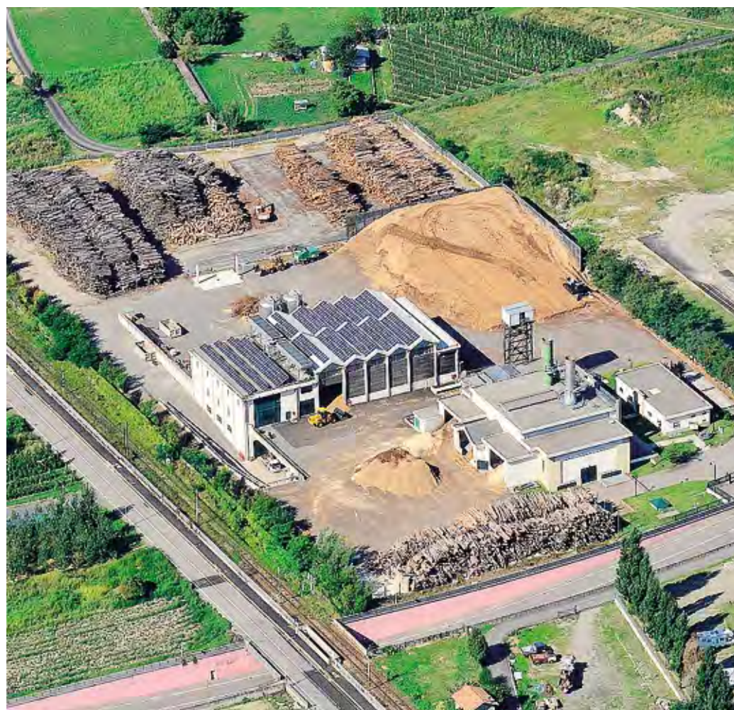
L'impianto di teleriscaldamento di Tirano
