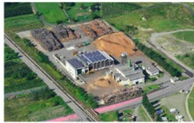
Centrale teleriscaldamento a Tirano, Lovere, Tovo e Mazzo stanno pensando di fare la stessa scelta. Non parleranno in assemblea
