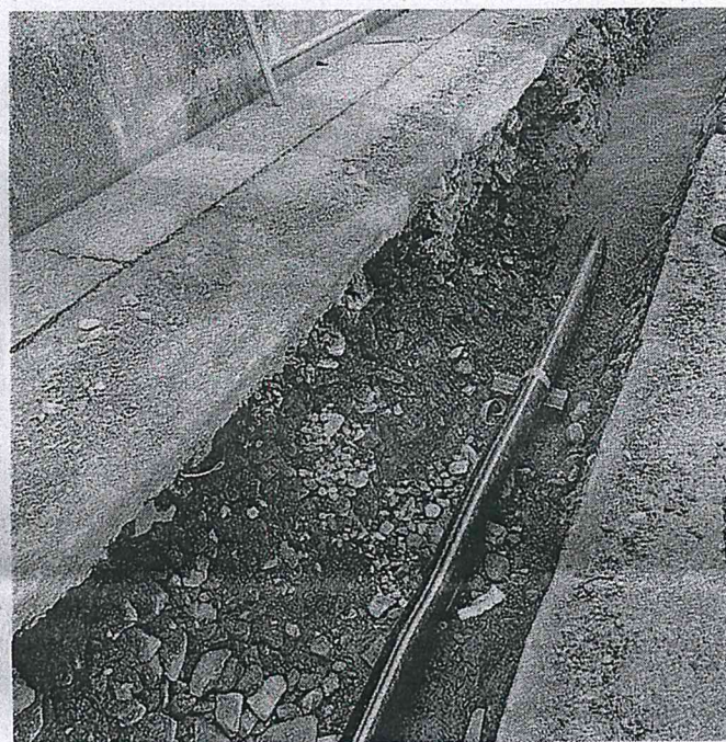
Scavi per la posa del metano
