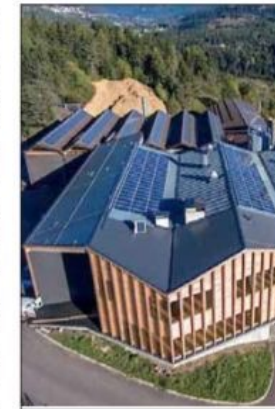
La centrale di teleriscaldamento
