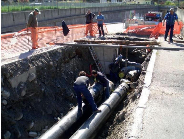
Figura 1 - Posa rete di teleriscaldamento. Fonte: Fiper
