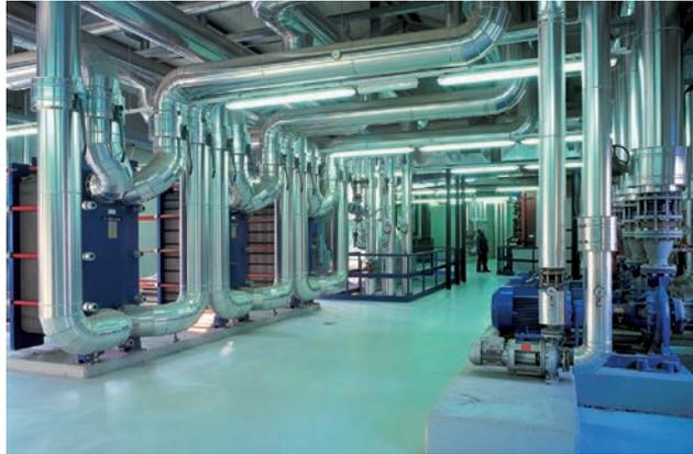
Figura 2 - Interno centrale di teleriscaldamento. Fonte: Bioenergia Fiemme
