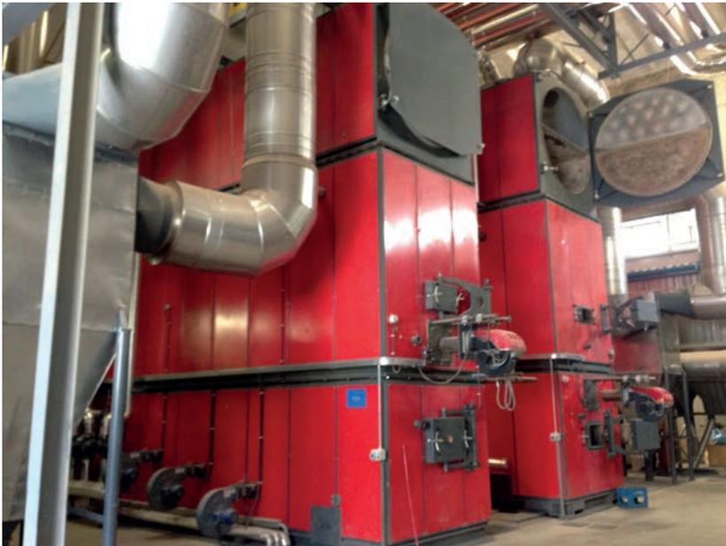
Figura 3 - Caldaia a biomassa da 2,5 MW termici. Fonte: Sosvav Temù (BS)
