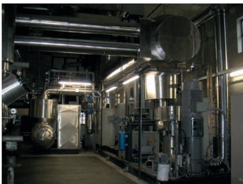
Figura 5 - Cogeneratore ORC presso impianto di TCVVV di Tirano. Fonte: TCVVV
