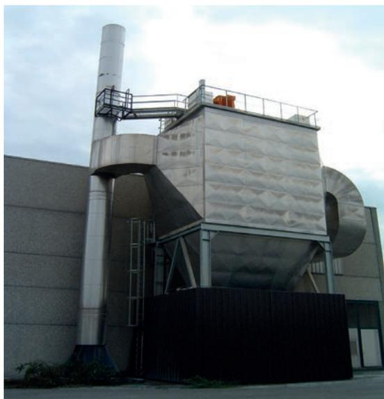
Figura 4 - Elettrofiltro . Fonte: Provana Calore
