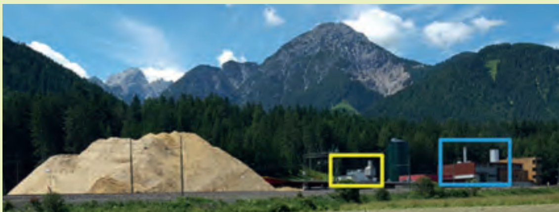
Vista dell'impianto: in giallo la caldaia da sostituire e in azzurro la caldaia a biomassa attualmente collegata al modulo ORC
