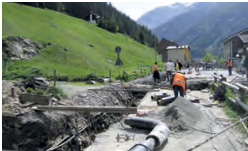
Figura 1. Installazione di una rete di teleriscaldamento in comune alpino (fonte: Giovanni Riva)
