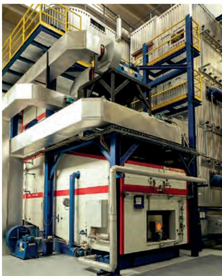
Figura 4. Caldaia a biomassa in una centrale termica di un impianto di teleriscaldamento (fonte: Giovanni Riva)
