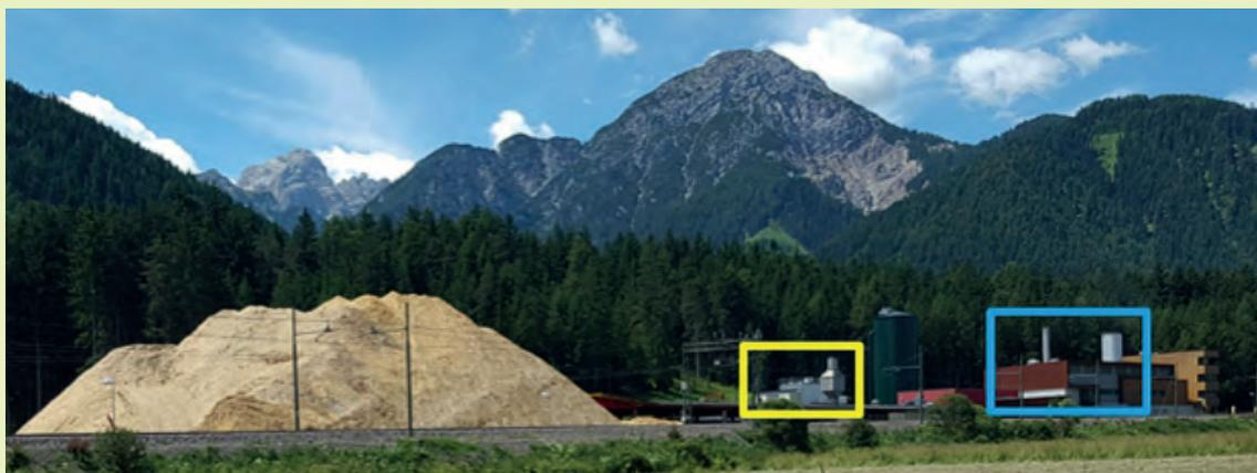
*Vista dell'impianto: in giallo la caldaia da sostituire e in azzurro la caldaia a biomassa attualmente collegata al modulo ORC*
